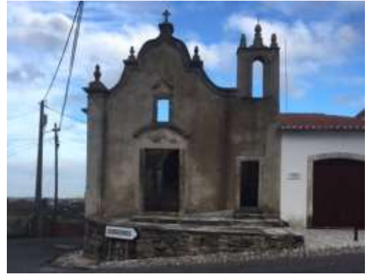
Ruínas da Capela de São Sebastião
