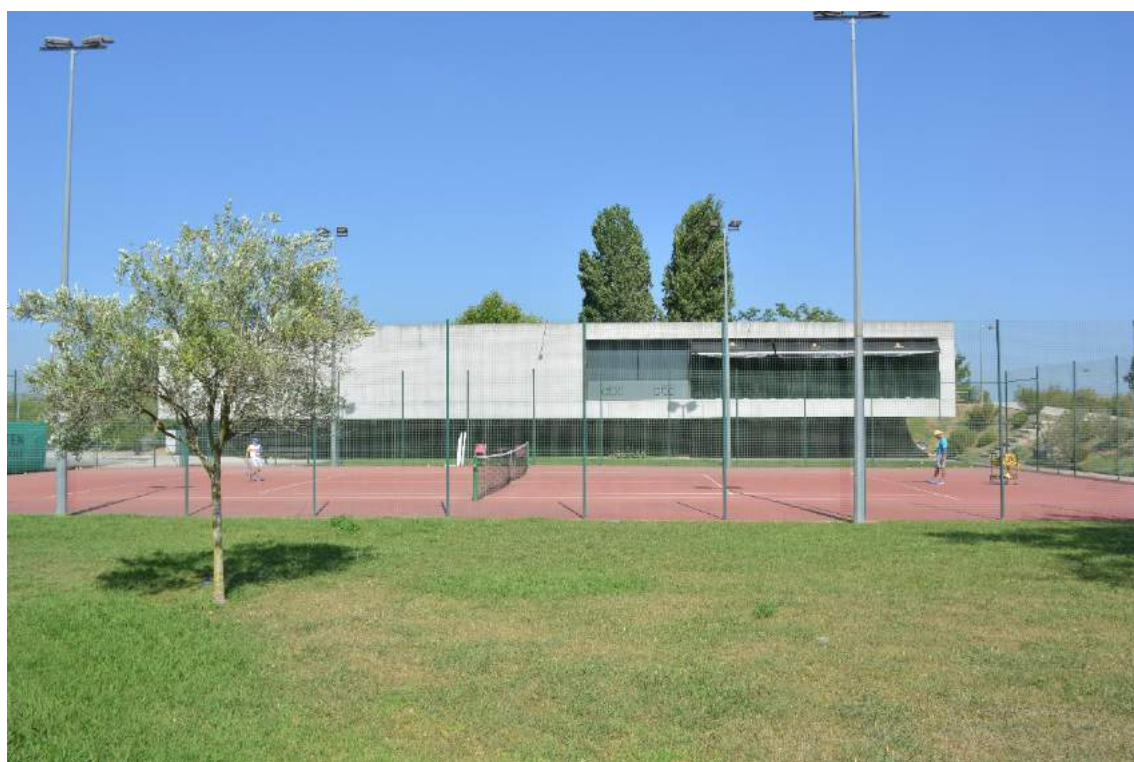
EDIFICIO DE APOIO
