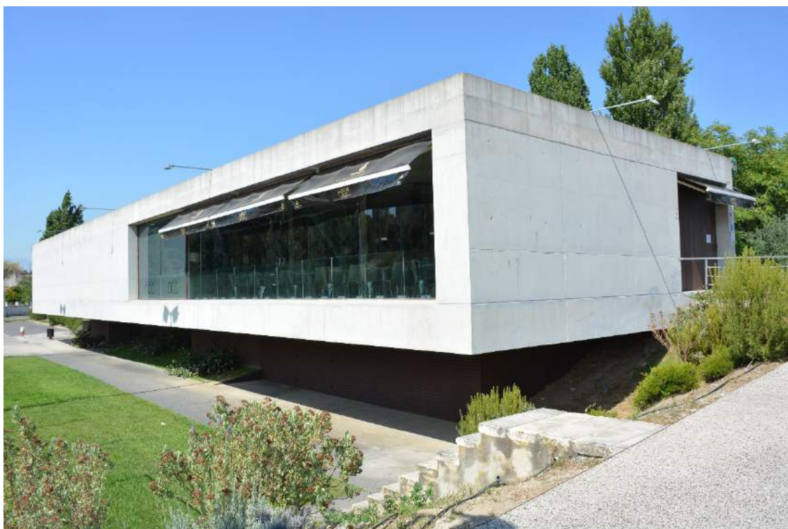
EDIFICIO DE APOIO
